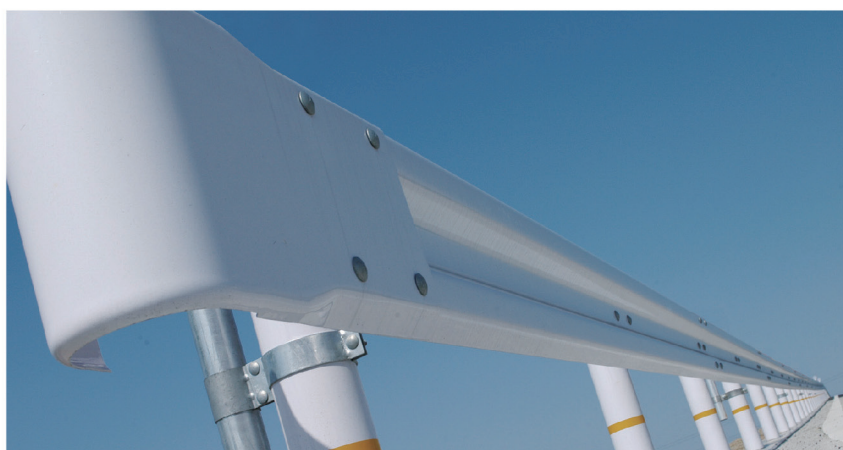
ガードレール Guardrails
