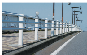
ガードパイプ Guard pipes
